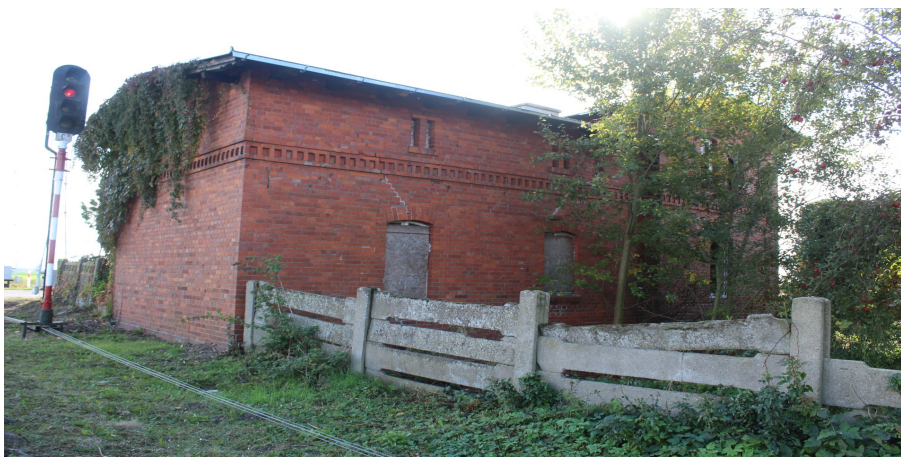
Ilustracja 142. Silno ul. Dworcowa 56, budynek kolejowy.
