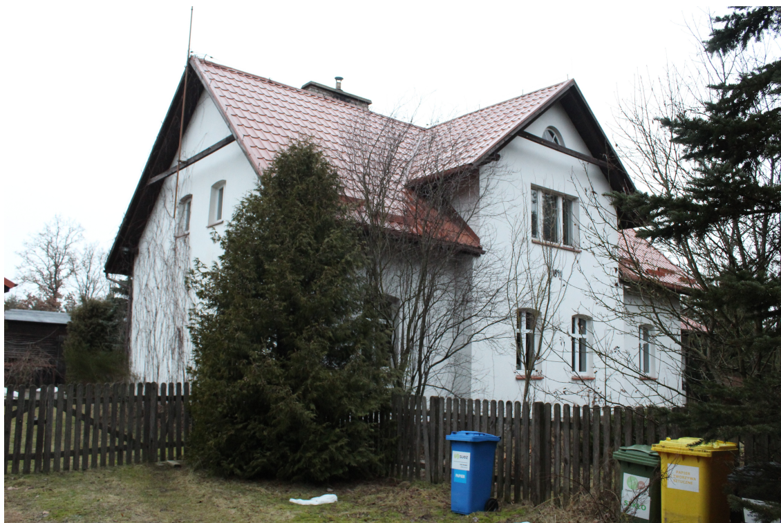
Ilustracja 150. Krojanty Wybudowania 2, budynek leśniczówki.
