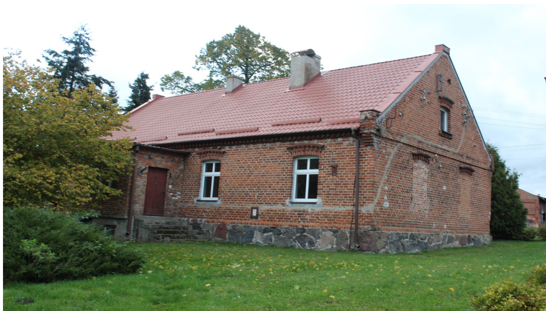
Ilustracja 129. Granowo 18, budynek świetlicy.
