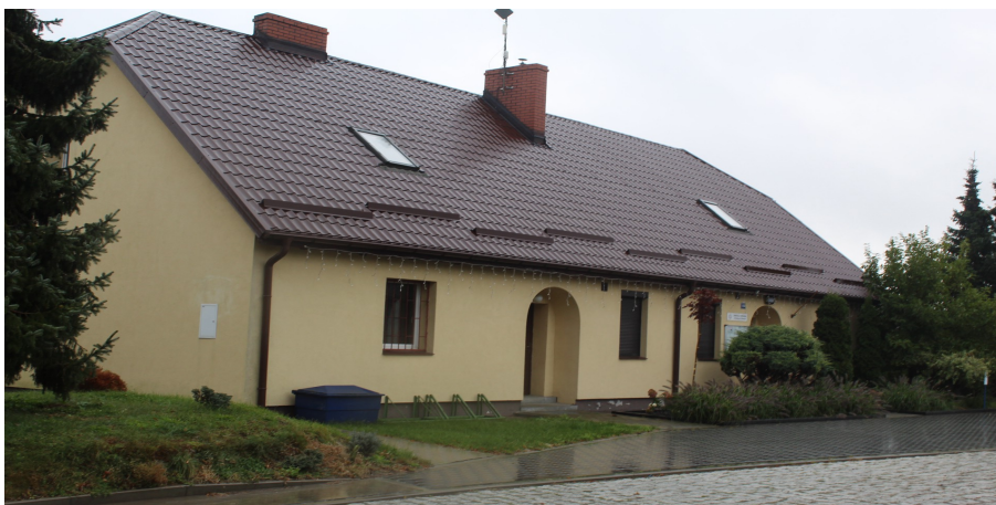
Ilustracja 136. Nowy Dwór 19, budynek dawnej świetlicy.
