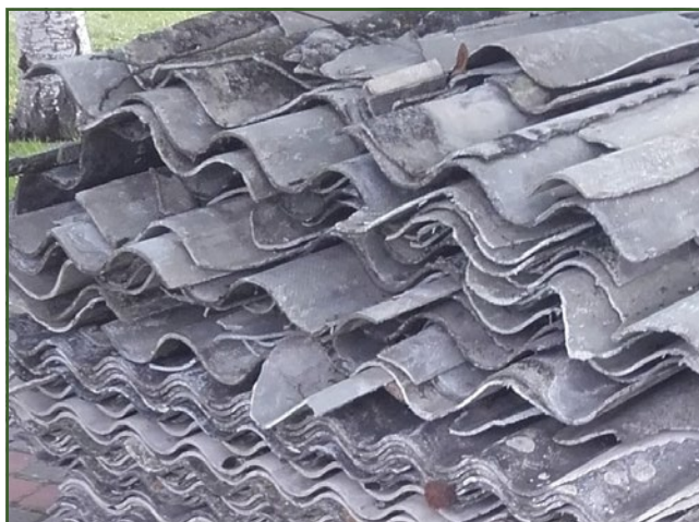
Wyroby azbestowe zabezpieczone i przygotowane do transportu celem utylizacji
