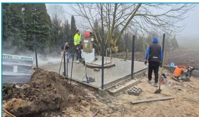
Przebudowa istniejącej przepompowni ścieków PS-48 w m. Sławęcín.
